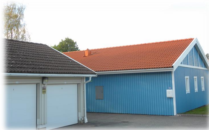
Föreningslokalen "Blå huset" efter takrengöring och målning
